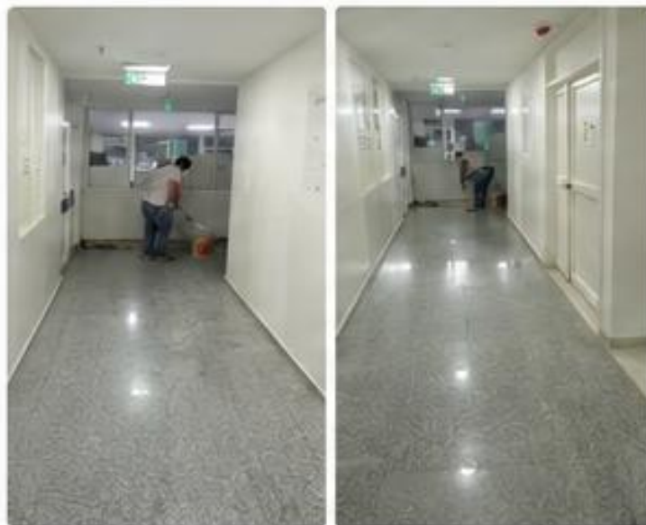
Pintura pasillo urgencias
